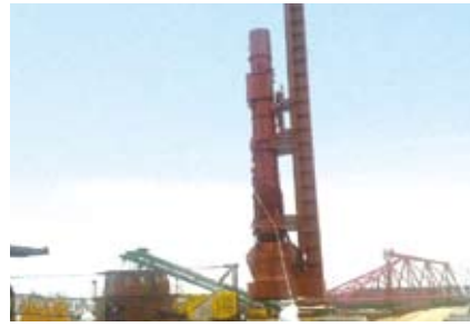
越南岬港码头D128柴油锤 Port of Da Nang, Vietnam. With D128
